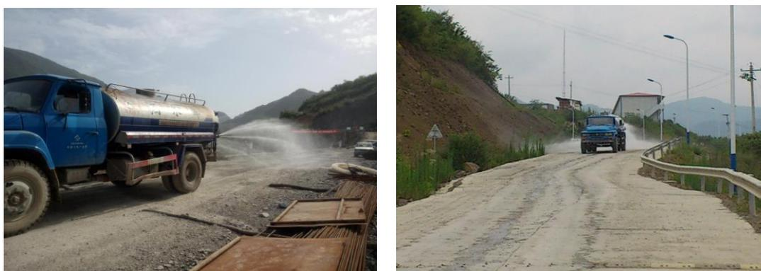
图 4.2-6 施工现场及施工道路洒水降尘
