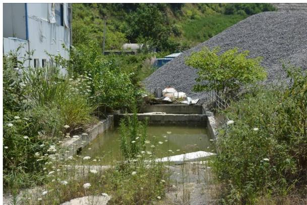
图 4.2-4 混凝土拌合系统生产废水沉淀池
